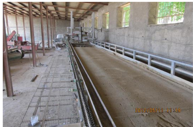
شکل ۲- انبار خاک کارگاه گروه مهندسی مکانیک ماشین‌های کشاورزی دانشگاه ارومیه
